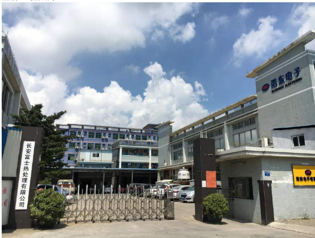
主体工程照片
