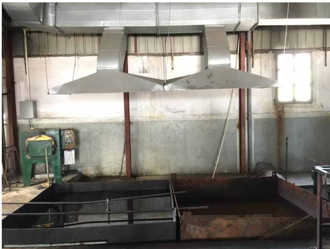
生产设备照片（淬火油池水池）
